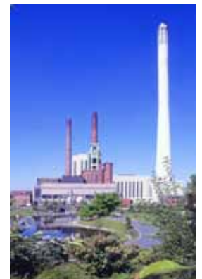
Heizkraftwerk Mitte: Herzstück der Braunschweiger Energieversorgung.
