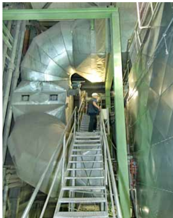
Über 1500 Quadratmeter Fläche wurden während der Sanierung sandgestrahlt und gereinigt.
